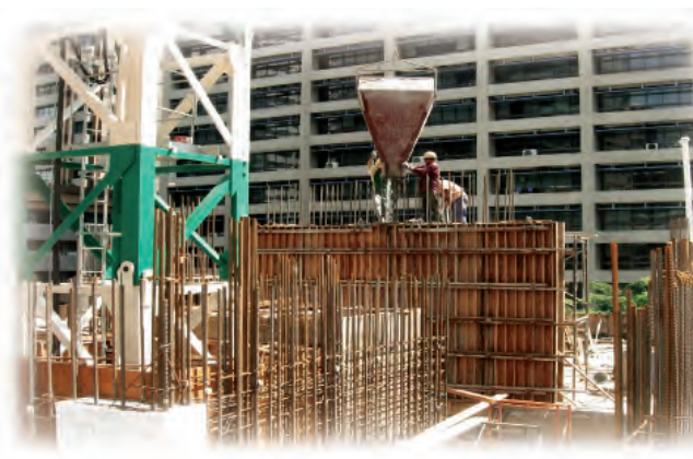
Kerja-kerja acuan untuk dinding lift sedang dijalankan di tingkat 6 hingga ke tingkat 7
