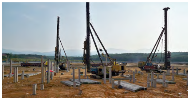
Kerja-kerja memasang cerucuk sedang dilakukan
